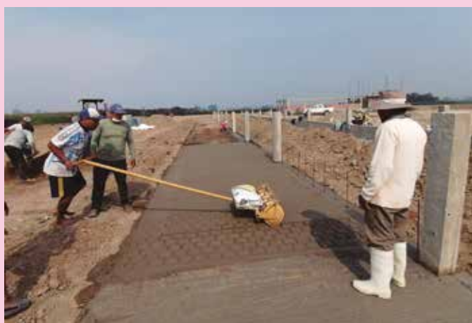
Orientación en diseño y monitoreo de avance en construcción de nuevas instalaciones en Sr. Ángel Cuadros García de Cañete, a cargo de nuestro supervisor técnico de campo zona centro M.V. César Alzamora Pinao.
