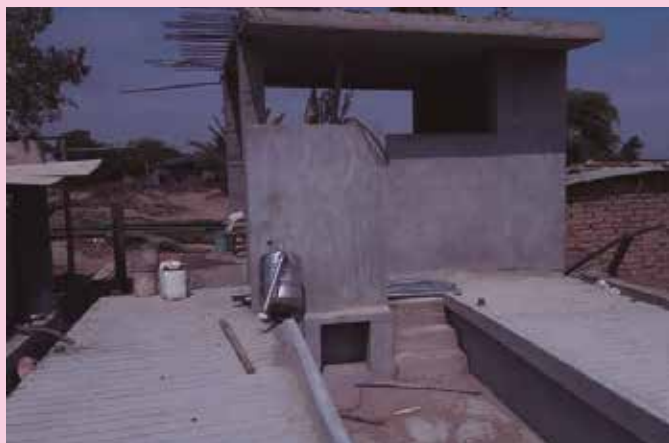
Seguimiento de construcción de nueva sala de ordeño espina de pescado en proveedor de Paján GANADERIA SAN PABLO S.A.C., por parte del asesor de campo Edwar Bustamante
