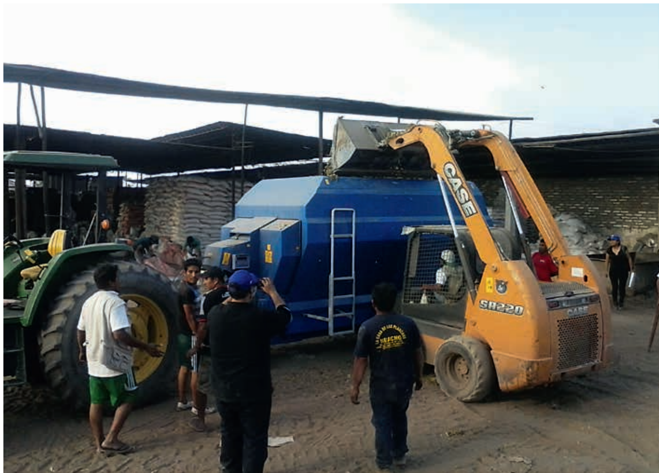
Mixers horizontales trabajando en CAMAY
